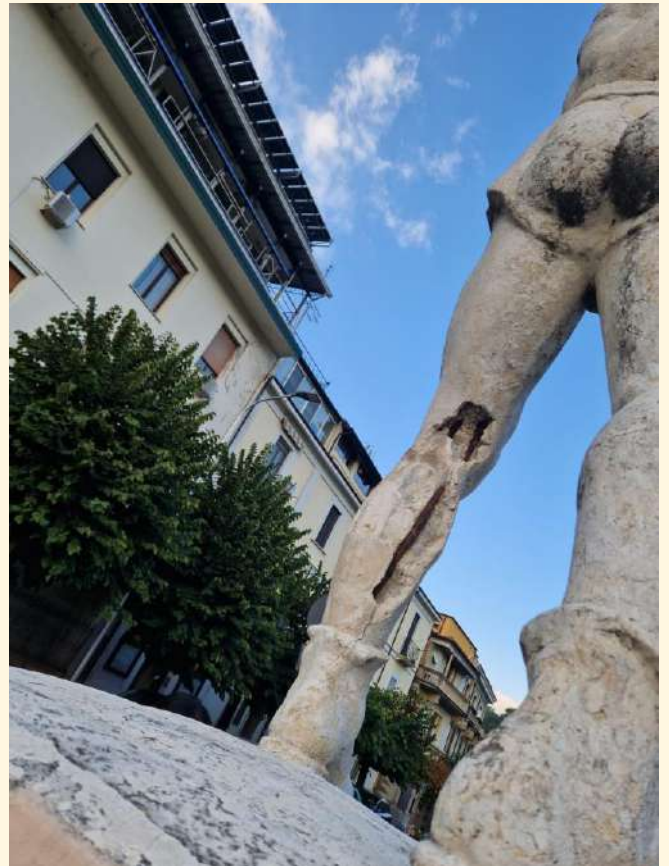
Foto 06 Elementi metallici non idonei
