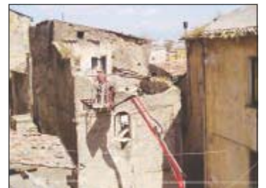
Le demolizioni in corso
